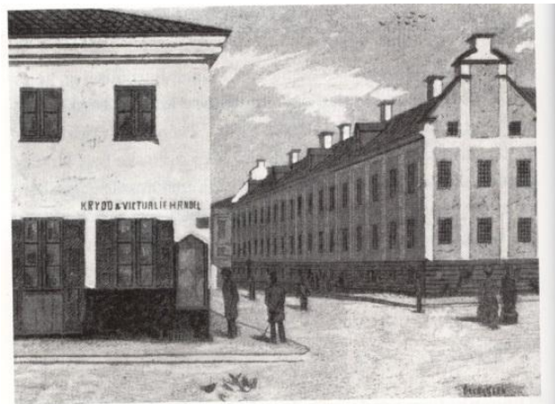
Allmänna Barnhusets gamla barnhusbyggnad sedd från hörnet Adolf Fredriks kyrkogata-Drottninggatan. Den var barnhusets huvudbyggnad i över 200 år och kritiserades ofta, bl.a. på 1840-talet för att "alla barnen var ättna av loppor och vägghyra; en beständig snusklukt" (Dr. Fr. Th. Berg). Tillhör Allmänna barnhuset.
