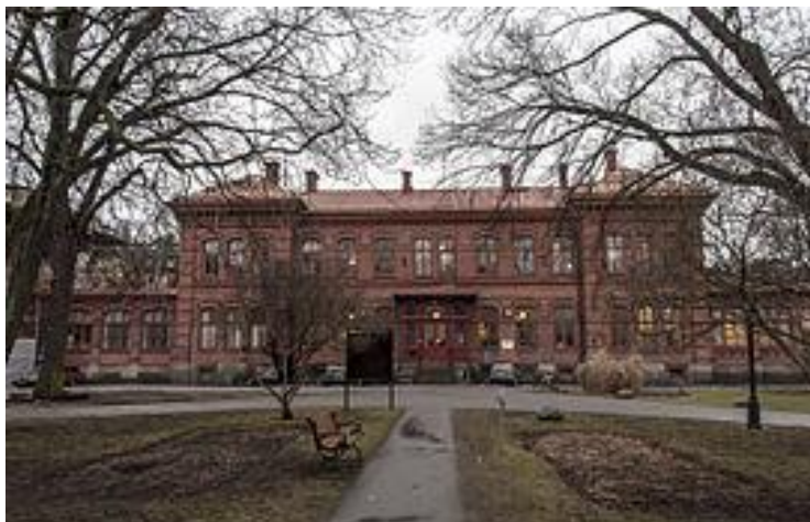
Det nya Allmänna Barnhuset/Norrtulls Barnsjukhus. Administrationshuset på Norrtullsgatan
