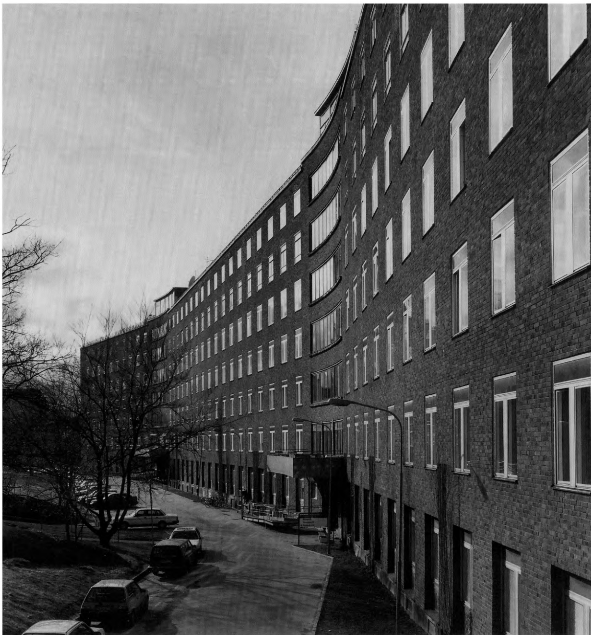
Huvudbyggnaden, parksidan The Main building, facing the park
