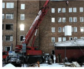
2001-01-22 Efter ombyggnationer i cyklotronhallen kunde strålskyddet och den nya cyklotronen lyftas in genom taket.
