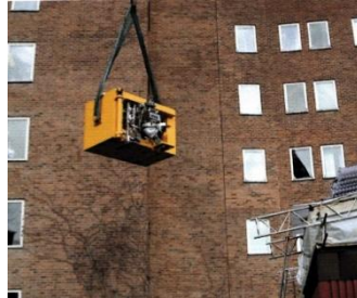
Efter demontering lyfts magneten för MC16 ut genom taket på cyklotronhallen för flytt till PET-verksamheten i Lund.
