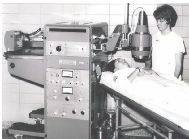
Rektilineär scanner (scintigraf) från omkring 1960. Den vänstra bilden visar utrustningen där detektorn som sveper över patienten hänger vertikalt. Den högra bilden visar spårämnesupptag i en hjärnförändring. De anatomiska referenserna är inritade i efterhand.
