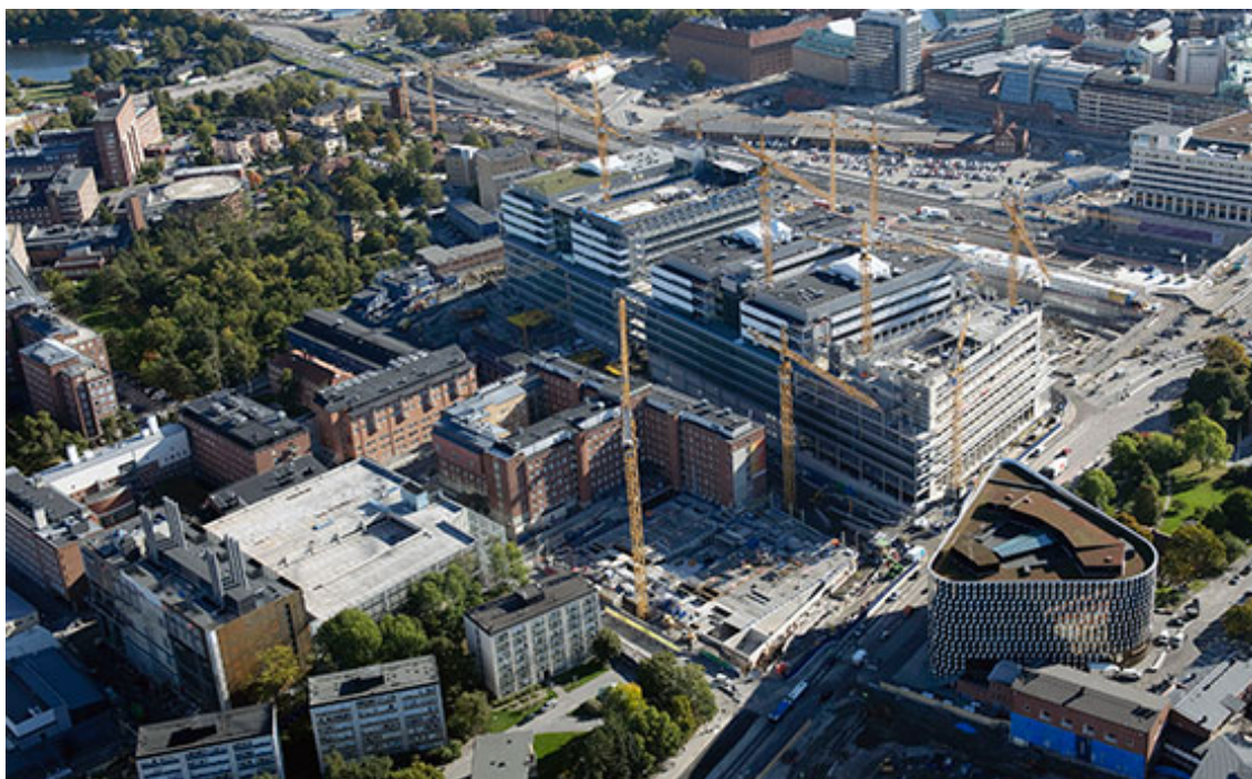
NKS under byggnation. Delar av thoraxhusen integreras i det nya sjukhuset.
