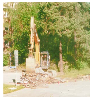
Grävskopan krossar garaget
