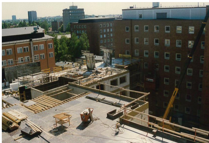
Flygel N10 och N11 byggs och blev färdiga 1997.
