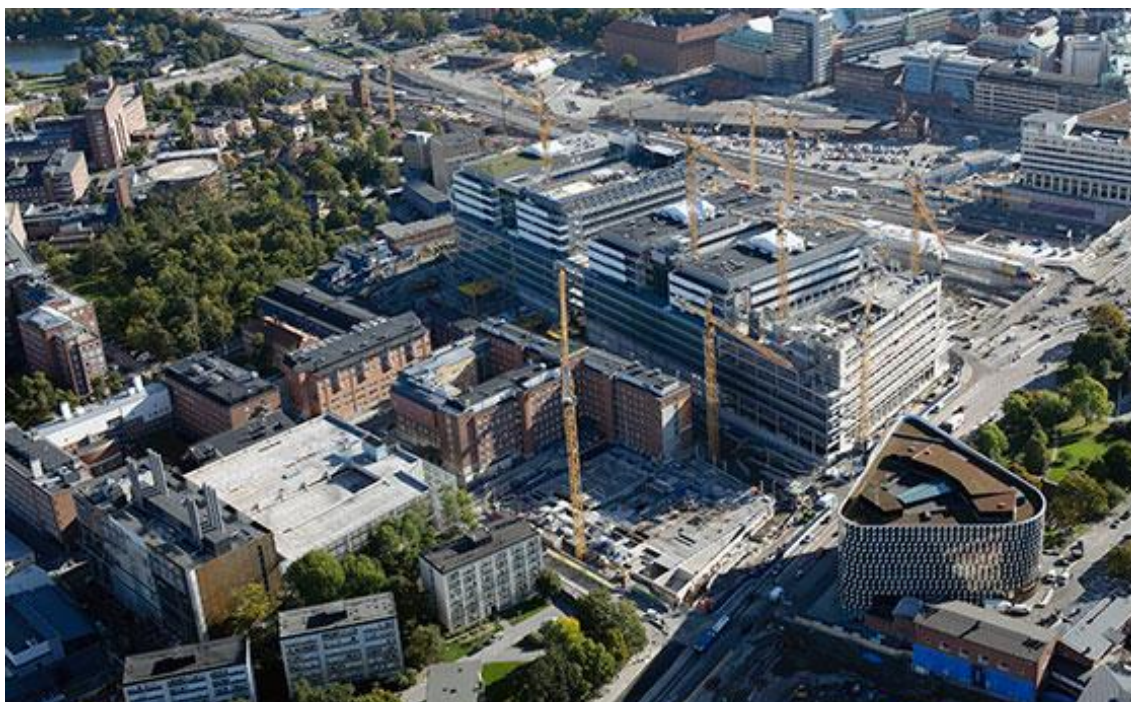
NKS under byggnation. Delar av thoraxhusen integreras i det nya sjukhuset.
